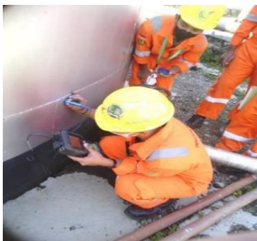
Gambar 2. Pengukuran ketebalan tangki menggunakan ultrasonic thickness gauge
