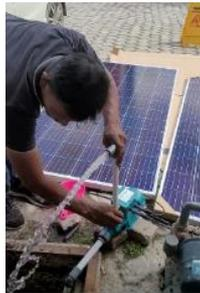
Gambar 14. Proses Penyambungan Charger Controller & Cek Pompa
