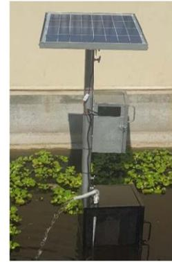
Gambar 16. Pompa Air Surya (Kolam Ikan)
